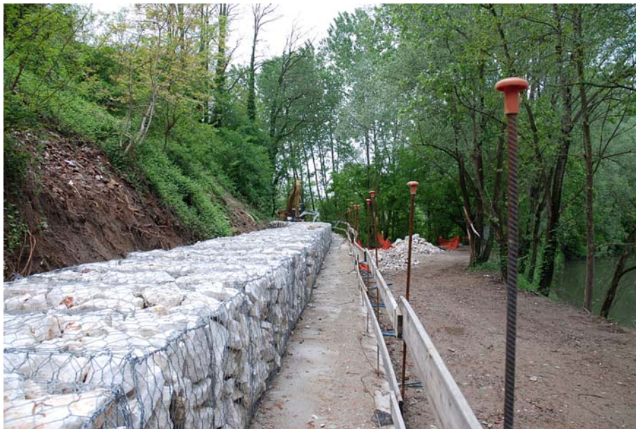
Aprile 2010 – Gabbionata al piede
