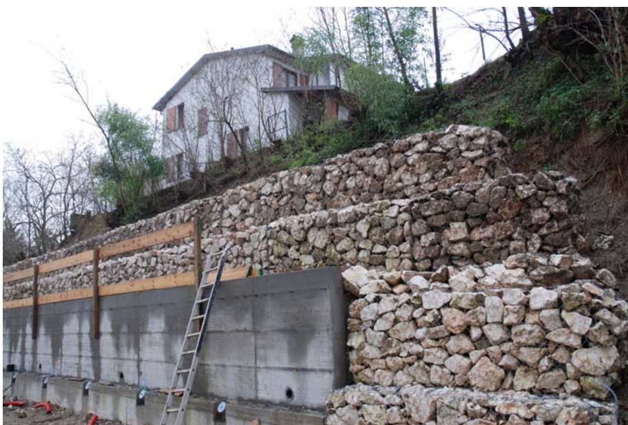
3 dicembre – Muro cemento armato e gabbioni
